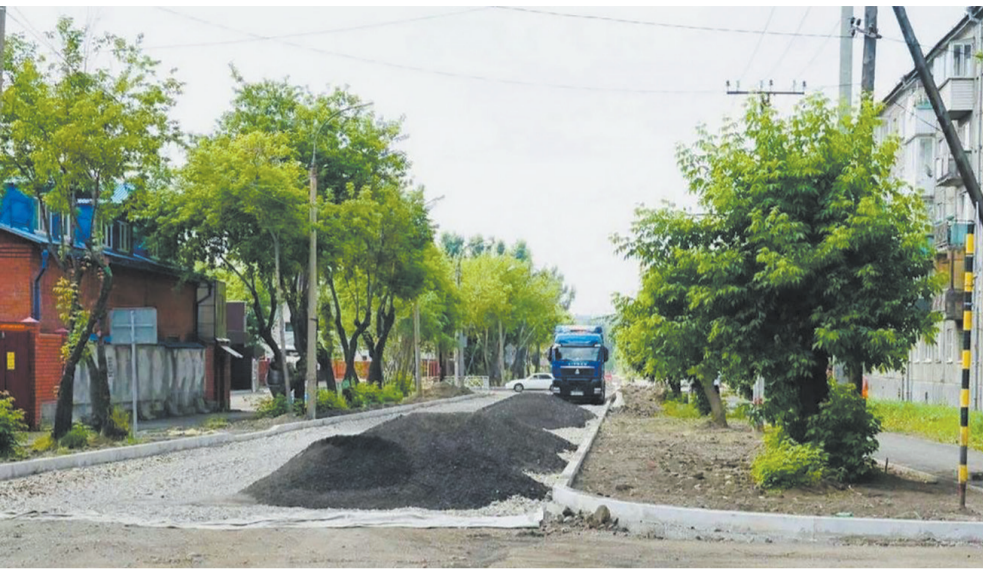
В рамках партийного проекта «Безопасные дороги» в июле 2023 года единороссы проверили ход ремонтных работ на дорогах Ленинского округа Иркутска. Модернизация городской дорожной сети проходит в рамках народной программы и партийного проекта «Безопасные дороги».
